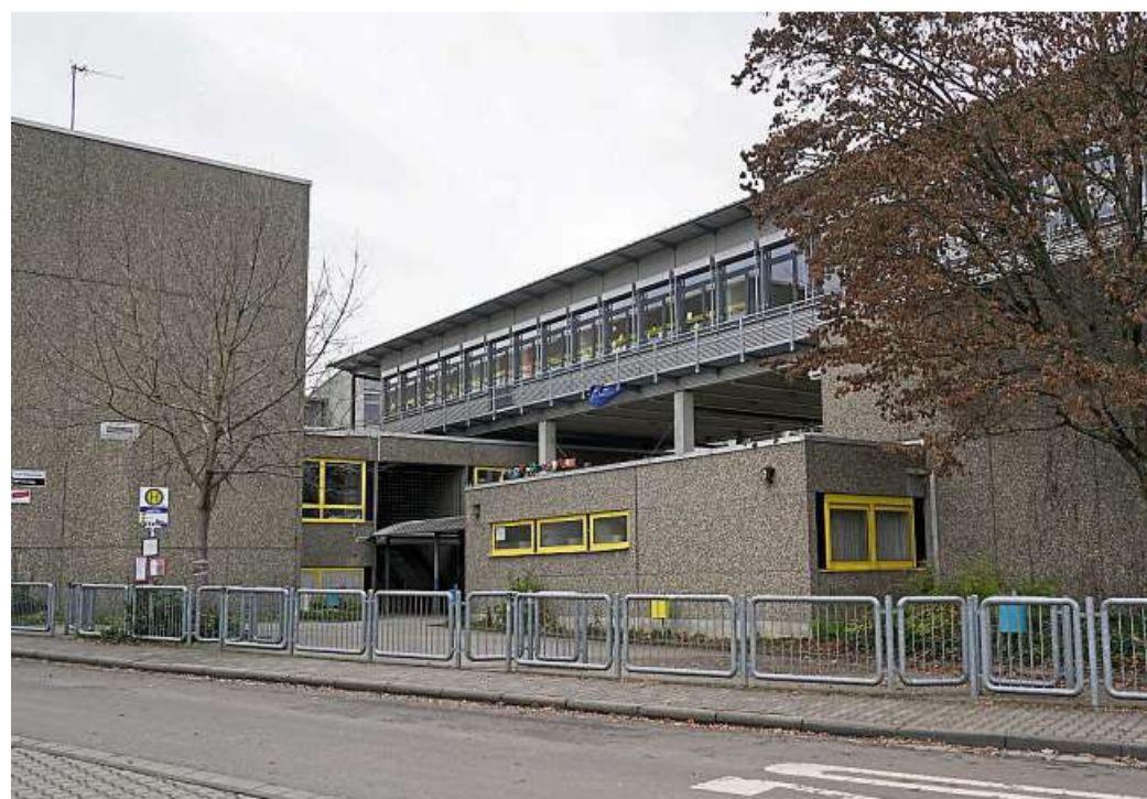
Am Hauptgebäude wie auch am denkmalgeschützten Altbau der Schule laufen derzeit Sanierungsarbeiten. Foto: Boris Korpak/pakalski-press
